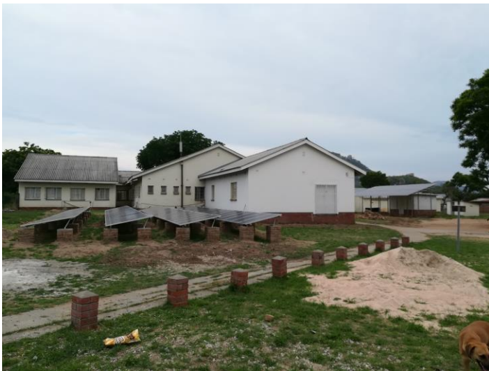
Due dei 3 impianti fotovoltaici attualmente operativi al LGH (sulla sx in primo piano, il nuovo impianto da 18 KW/h)
