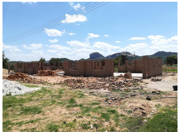
I 4 nuovi appartamenti in costruzione per il personale ospedaliero
